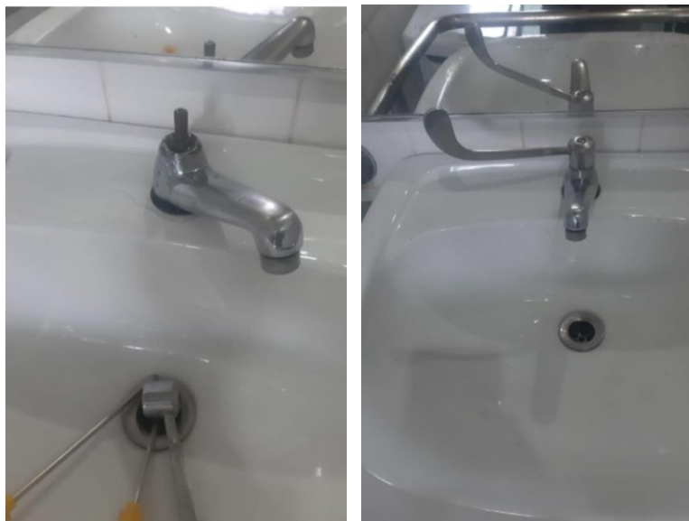
Figura 20: Manutenção em torneira.
