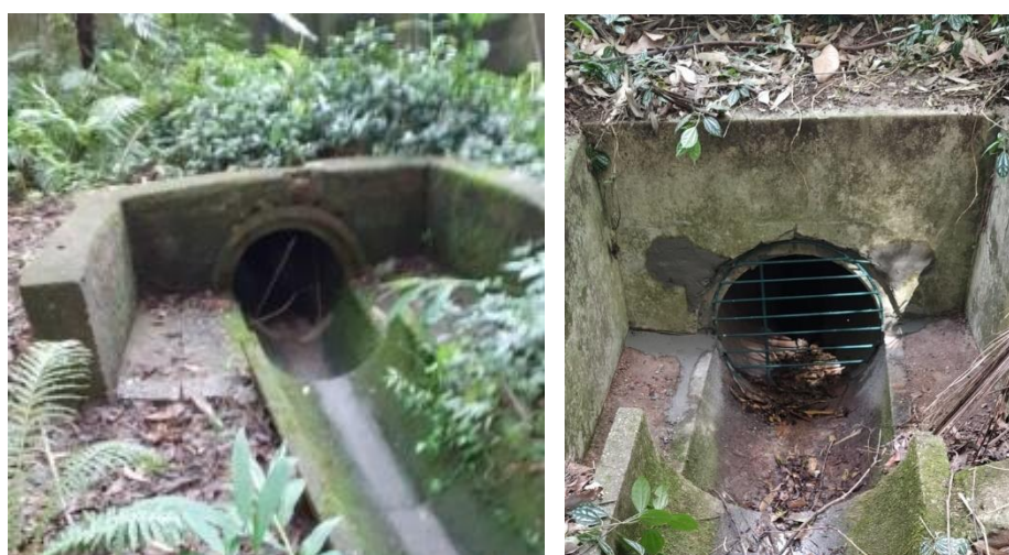
Figura 24: Instalação de grades de proteção nas bocas de galeria.
